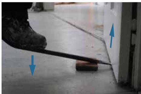
Avec la porte ouverte perpendiculairement par rapport au mur, placez le pied de biche ou burin sous la porte du côté charnières. Utilisez une cale pour éviter d'abîmer le sol. Faites levier avec votre pied tout en tenant chaque côté de la porte. Plusieurs tentatives peuvent être nécessaires. Soulevez et retirez la porte de ses gonds.
