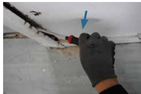
Enlevez le chambranle de la porte. Introduisez le burin entre le chambranle et le mur et faites levier. Commencez progressivement, du bas vers le haut. L'opération peut s'avérer délicate lorsque le chambranle est cloué. S'il s'agit de vis, dévissez celles-ci préalablement.
