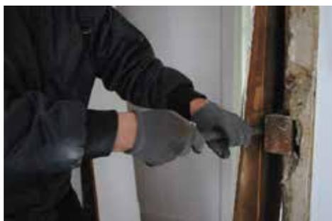
Récupérez l'ébrasement de la porte. Si l'ébrasement est fixé par des pattes de scellement, coupez celles-ci à la disqueuse. Dans le cas de vis de fixation, dévissez-les. Dans le cas où l'ébrasement est cloué ou collé, forcez à l'aide d'un burin et d'un maillet en faisant levier.
