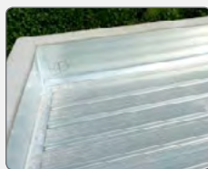
Toit terrasse isolé en sous face
