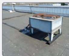
Toit terrasse sur bacs acier isolé
