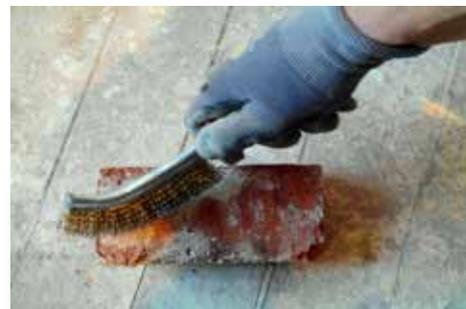
**3** Récupérez les briques et brossez-les une à une à la brosse dure jusqu'à enlèvement du gros résidu de mortier. Seules quelques traces superficielles de mortier peuvent subsister.
