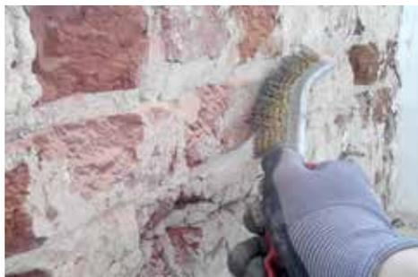
**1** Enlevez le plafonnage du mur au moyen d'un marteau-piqueur ou d'un burin, puis d'une brosse métallique. Dans les vieilles maisons bruxelloises, traditionnellement, les murs étaient enduits d'un mélange de chaux, sable et poils de vache, avant d'être recouverts d'une fine couche de plâtre.
