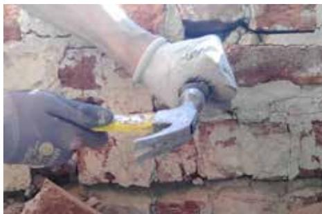
**2** Repérez qu'il s'agisse bien de briques pleines récupérables maçonnées au mortier chaux (couleur blanc), cendre (couleur gris), d'argile (résidus de foin présents). Si c'est le cas, à l'aide d'un marteau piqueur ou d'un burin, **désolidarisez les briques** une à une.
