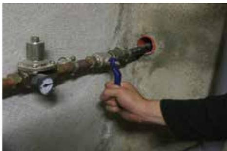
En absence de vannes d'arrêt ou de paralysie de celle-ci (pour cause d'entartrage), fermez la vanne générale située après le compteur d'eau. Ouvrez ensuite complètement le robinet afin de vider les canalisations.
