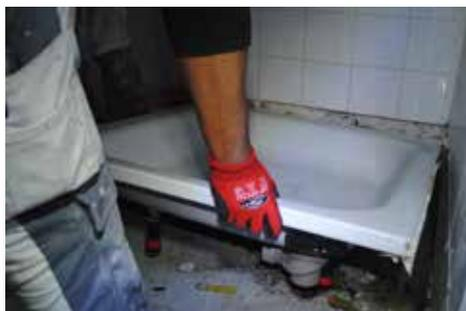
Retirez le bac du mur. Desserrez et démontez ensuite les bagues de fixation qui retiennent la bonde (à la main ou à l'aide d'une pince multiprise).
