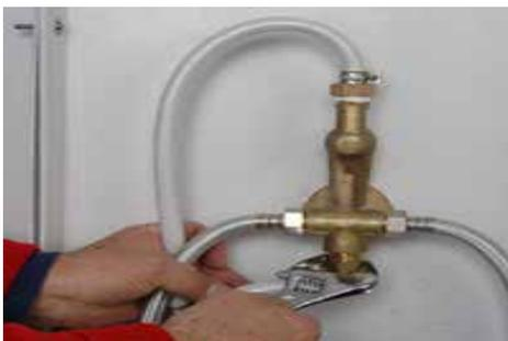
Dévissez les raccords d'alimentation des flexibles à l'aide d'une clé à molette et d'une pince multiprise, et terminez à la main. Il restera toujours un petit peu d'eau, prévoyez un bac ou chiffon sous les raccords. Si vous avez coupé la vanne du compteur, bloquez les raccords d'arrivée par des bouchons collecteurs adéquats.
