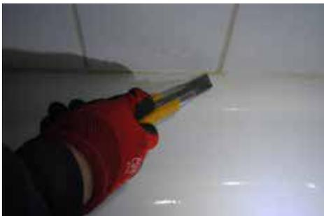
A l'aide d'un cutter découpez les joints. Dégagez ensuite la cabine ou le bac pour accéder au flexible de raccordement et au système d'évacuation. Le bac est parfois encastré dans le carrelage, vous devrez alors le libérer en cassant délicatement les carrelages à l'aide d'une massette et d'un burin.
