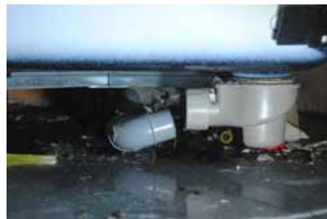
Désolidarisez le système d'évacuation de la bonde. L'assemblage peut être :
