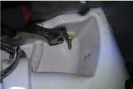
A l'aide d'une clé plate dévissez complètement les fixations maintenant le lavabo contre le mur. Soulevez ensuite et retirez le lavabo du mur ou du plan de travail. Suivant l'état, récupérez ou non le système de fixation.
