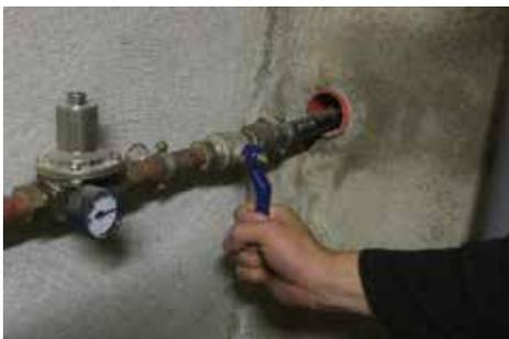
En absence de vannes d'arrêt ou de paralysie de celles-ci (pour cause d'entartrage), fermez la vanne située après le compteur d'eau et ouvrez ensuite complètement le robinet afin de vider les canalisations.
