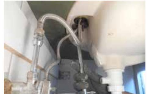
Dans le cas de la récupération de la robinetterie uniquement, dévissez la bague de fixation du robinet à l'aide d'une clé de lavabo. Prenez soin d'avoir préalablement désolidariser le système d'arrivée et d'évacuation d'eau.
