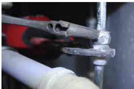
Dévissez les raccords d'alimentation des flexibles à l'aide d'une clé à molette et d'une pince multiprise, et terminez à la main. Il restera toujours un petit peu d'eau, prévoyez un bac ou chiffon sous les raccords.
