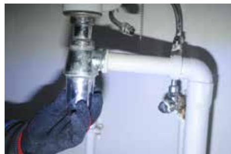
Placez une bassine sous le siphon, et dévissez le culot du siphon (à la main ou à l'aide d'une pince multiprise). Récupérez les déchets dans la bassine.
