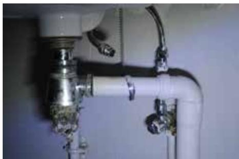
Desserrez et démontez ensuite les différentes bagues filetées qui retiennent le siphon et le système de bonde (à la main ou l'aide d'une pince multiprise).
